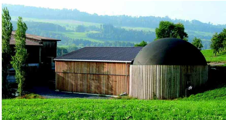
Usina de Biogás numa região rural da Suíça Biogas Plant on Swiss Farm
