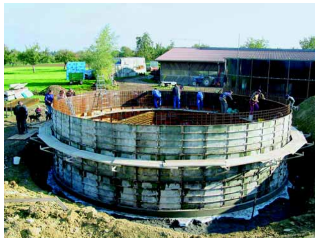
Construção de um biodigestor Construction of a Biodigester
