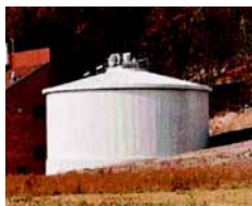
Digestão anaeróbia de lodo
