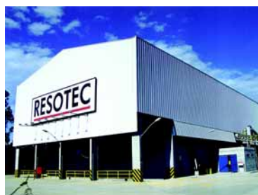
Estação de tratamento de resíduos
